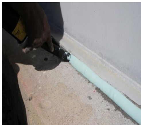
Рис. 2. Нанесение пенополиуретана на конструктивные элементы крыши
