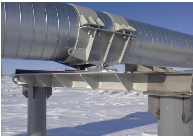
Рис. 7. Подвижные опоры нефтепровода
