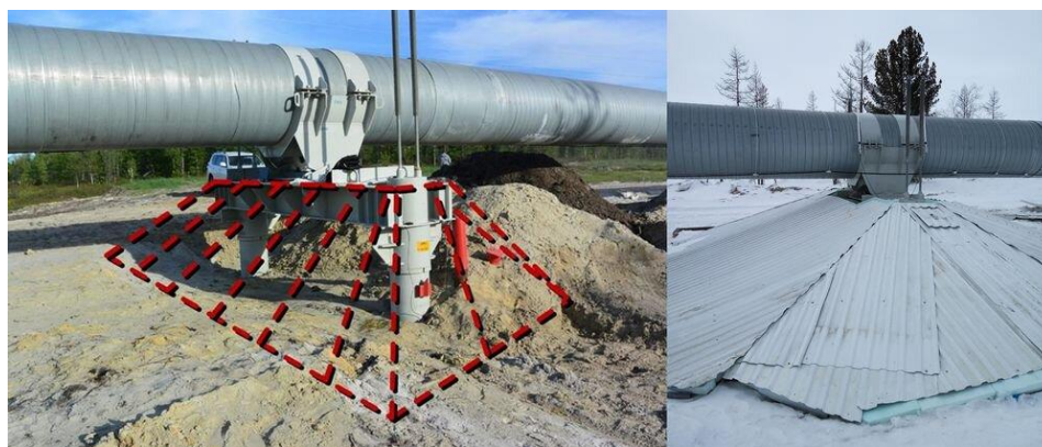
Рис. 6. Термоизолирующий экран нефтепровода
