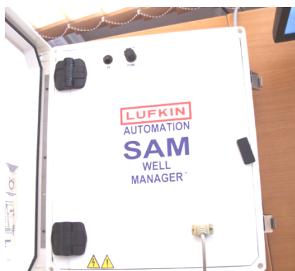
Рис. 2. Контроллер, управляющий режимами работы добывающих скважин
