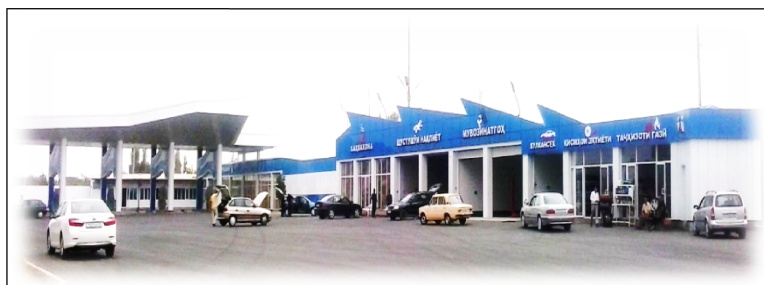
Рис. 2. АЗС в г. Худжанд с дополнительными сервисами
