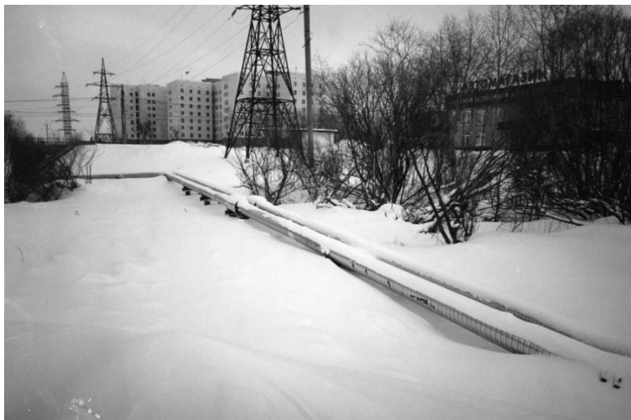
Рис. 1. Наземная прокладка теплопроводов в ППУ-изоляции
