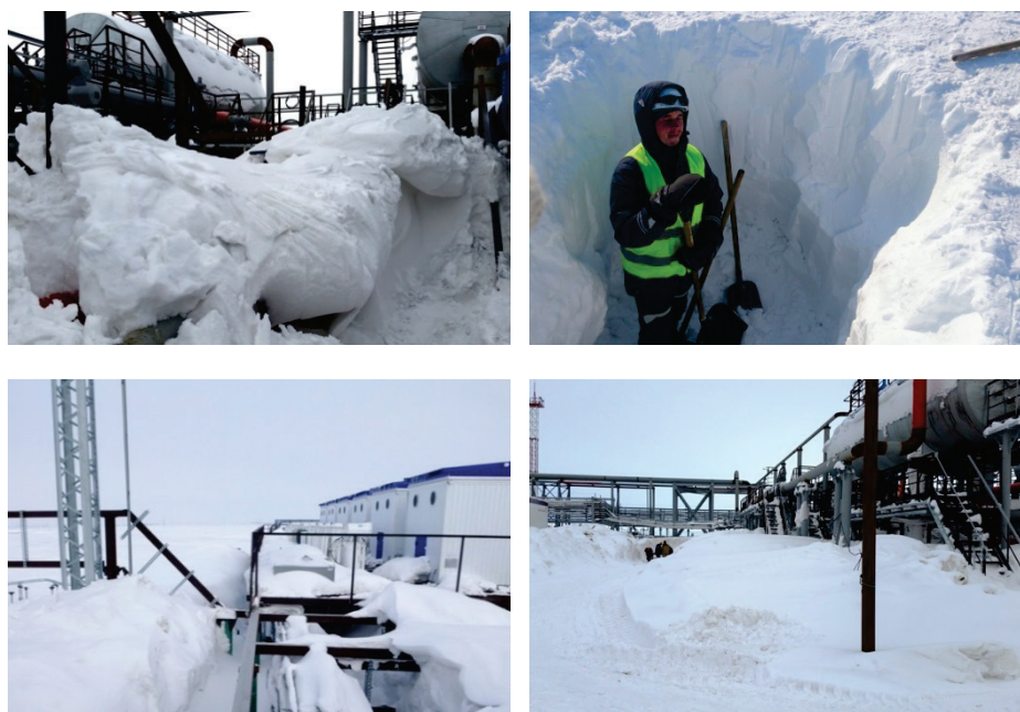
Рис. 1. Снегонакопление на объектах нефтегазовых месторождений в тундровой зоне
