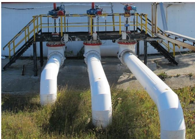
*Рис. 1. Узел приема и раздачи нефти РВСП-20000*
